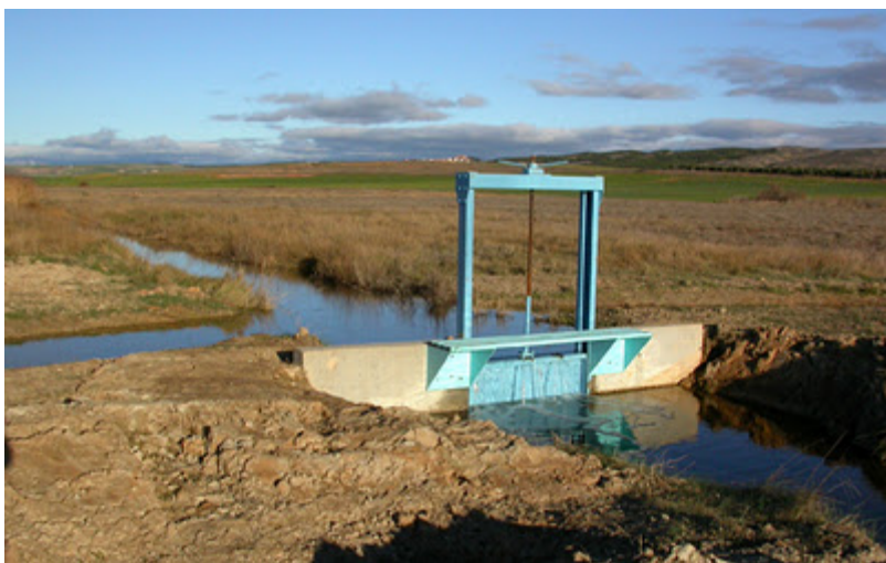
Una de las esclusas instaladas en los canales para retener el agua en la zona.
